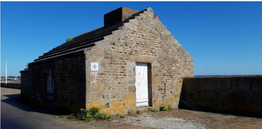
Le bâtiment du corps de garde
