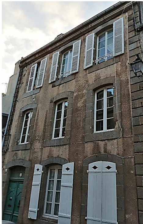
Au 49 rue Saint-Jean, la maison louée en 1792 par la mairie de Granville au sieur Longueville de la Clémentière pour y installer la nouvelle école d'hydrographie
